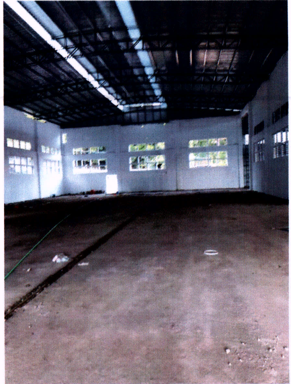
厂区厂房现状图 2
