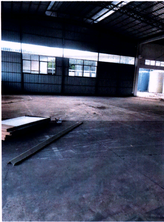
厂区厂房现状图 1
