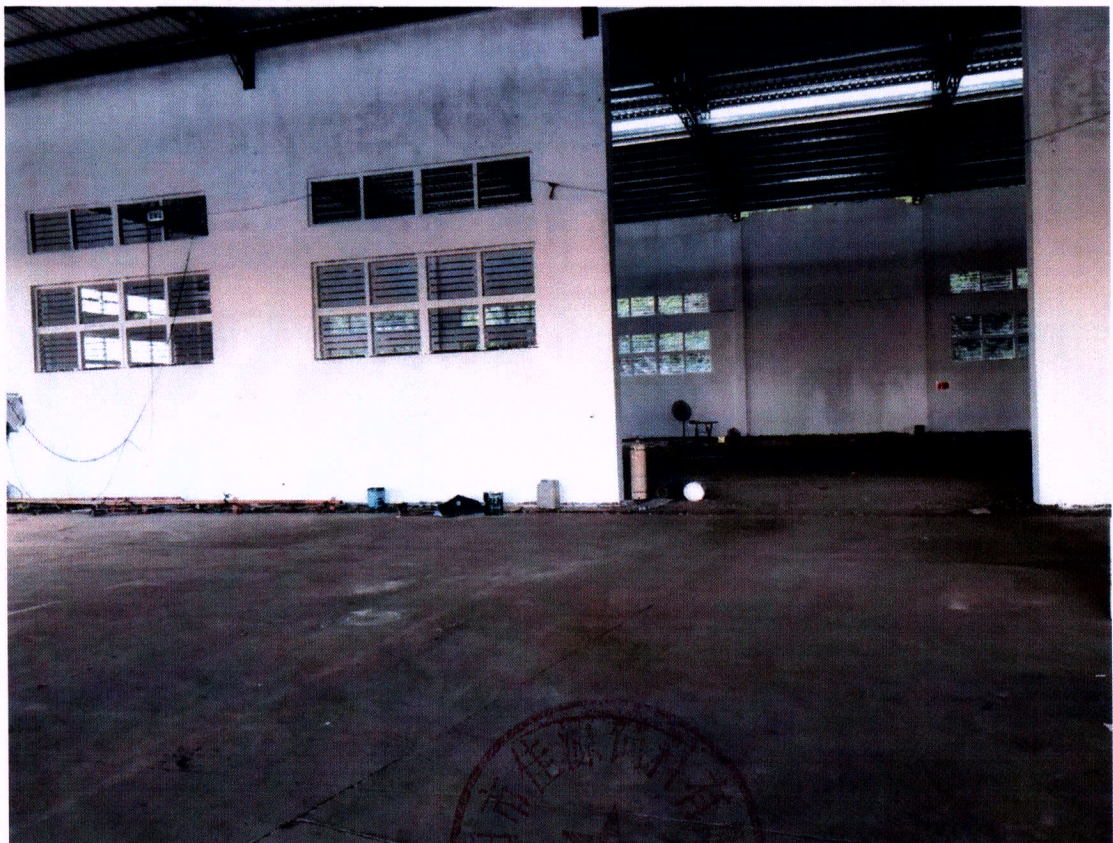
厂区厂房现状图 3
