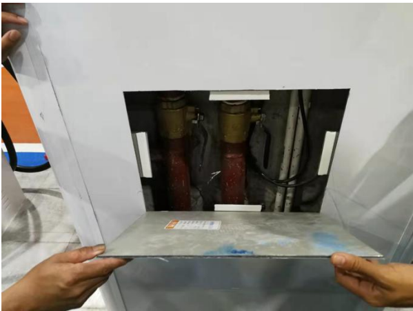
油气回收设施
