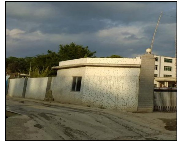
项目所在位置建筑物现状
