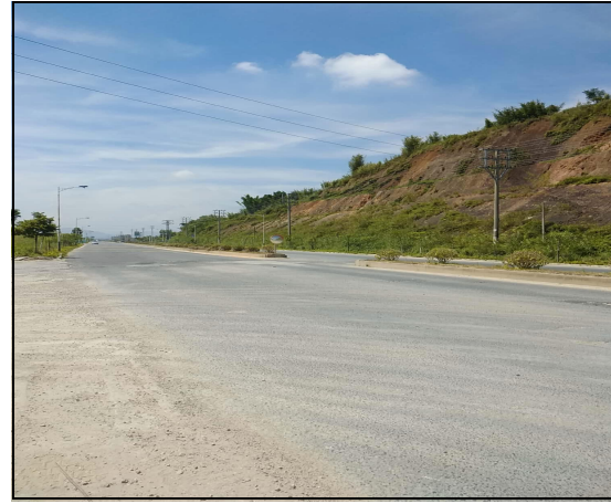
项目北面京棉路
