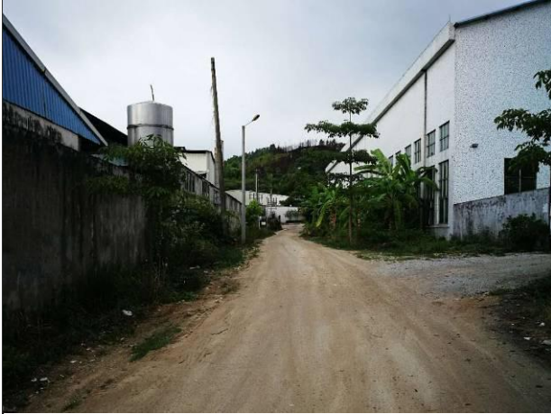
东面厂区前道路
