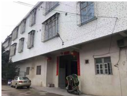
3#厂房西北面工业厂房
