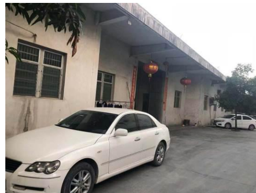
2#厂房西南面工业厂房
