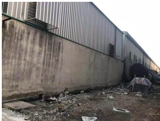
1#厂房东南面工业厂房
