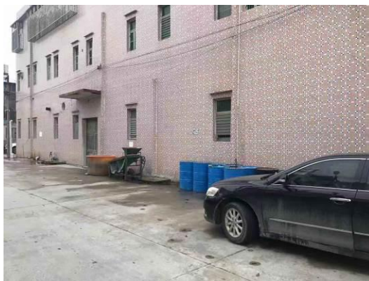
3#厂房东南面工业厂房
