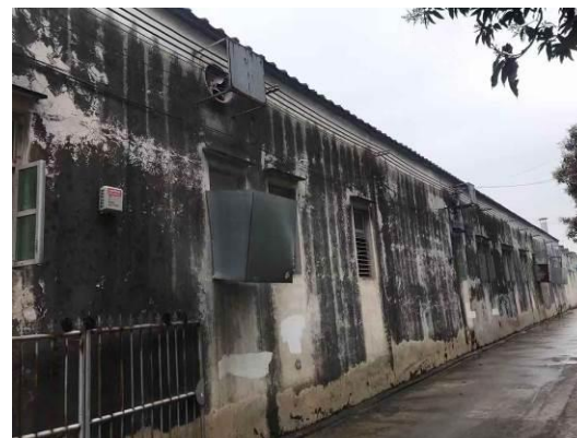
3#厂房西南面工业厂房
