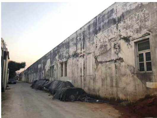
1#厂房西北面工业厂房
