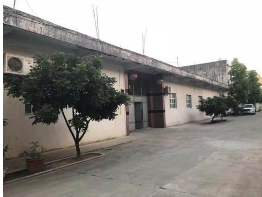
1#厂房东南面工业厂房
