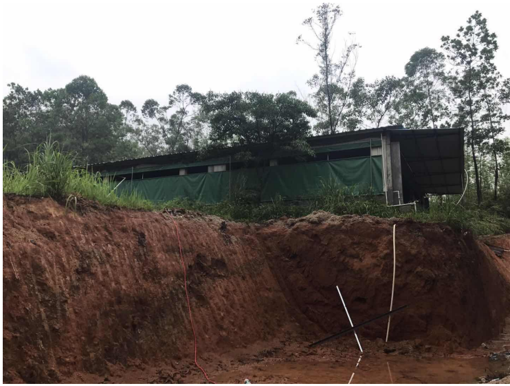
项目北侧：其它厂房
