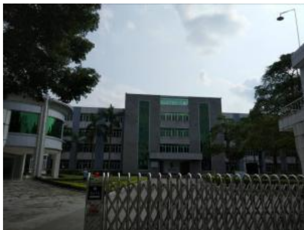
项目位置现状
