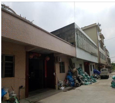
项目东南面工业用房
