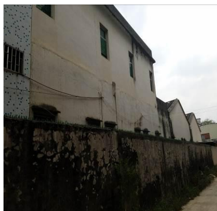
项目东北面工业厂房
