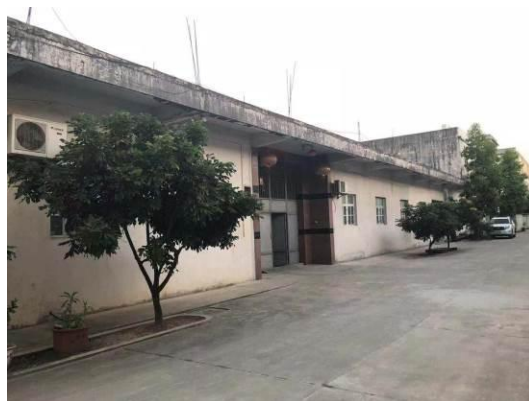
1#厂房东南面工业厂房
