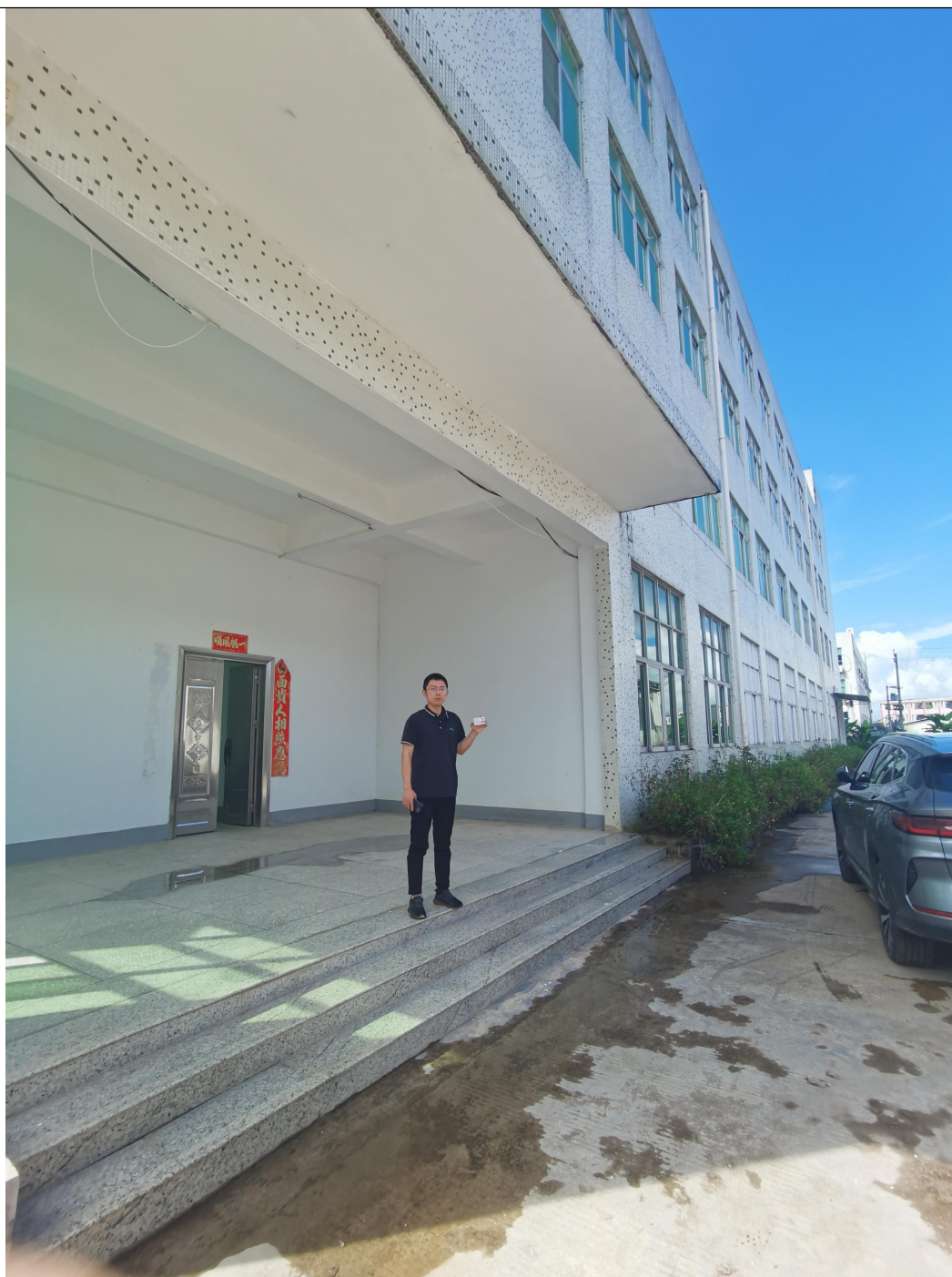
现场勘查照片
