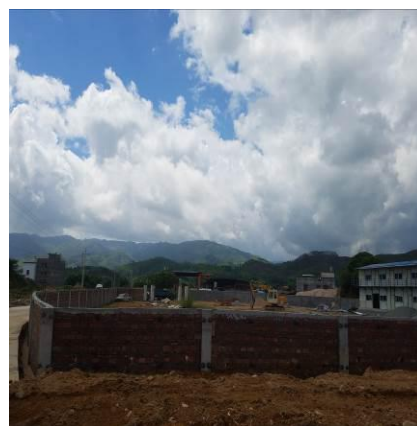
项目南面在建厂房
