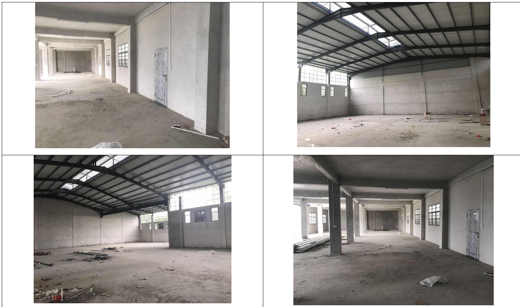
附图 5 项目厂房现状
