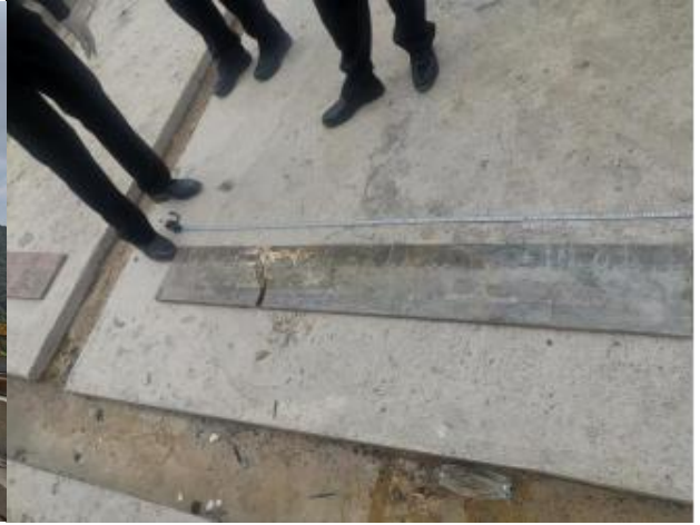
图 2 事故现场起重机东侧下方白色木板
