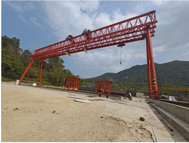
图 1 事故现场起重机
