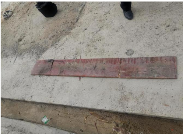
图 3 事故现场起重机东侧下方红色木板
