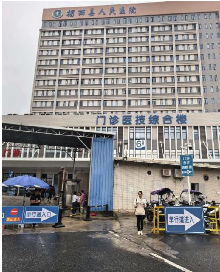
工程师现场勘察照片：
