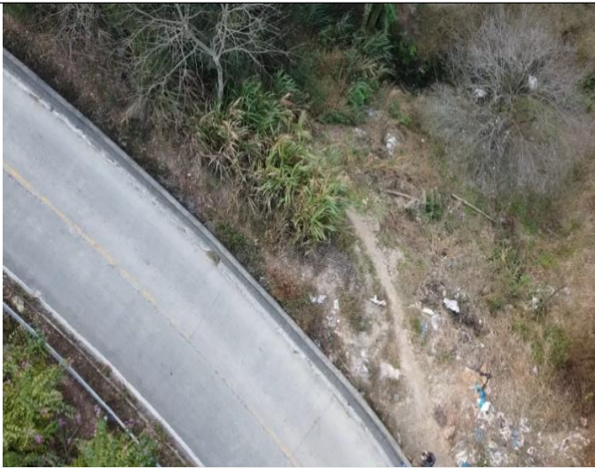
项目东南面 95m 乡村道路
