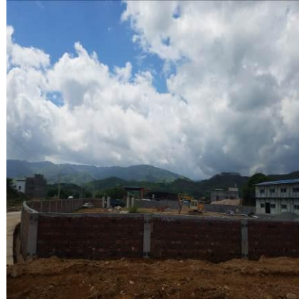
项目南面在建厂房
