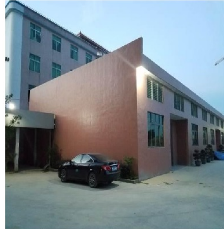
项目北面工业厂房
