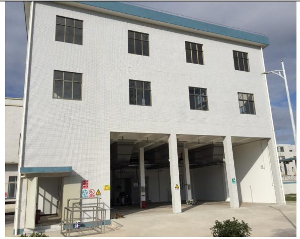
脱泥房，一楼是污泥泥斗
