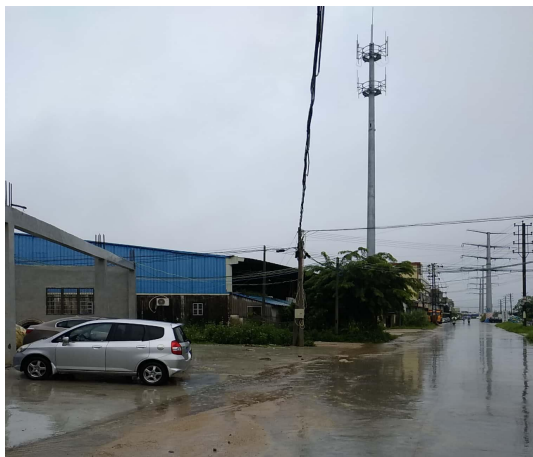
项目东面 工业厂房
