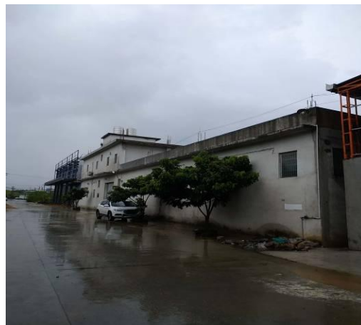
项目北面 工业厂房
