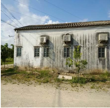
项目北面工业厂房
