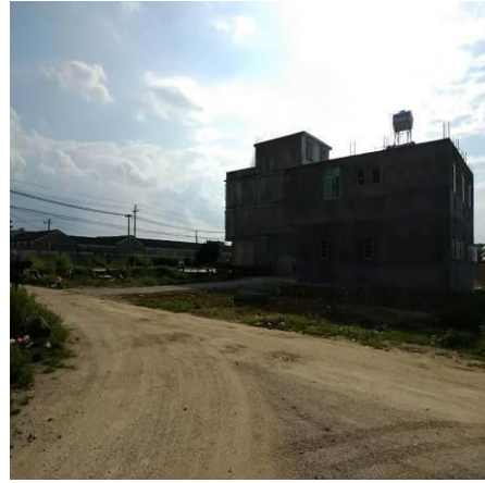
项目西南面工业厂房
