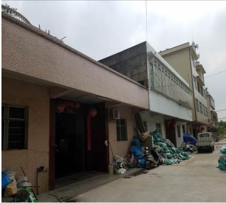
项目东南面工业用房
