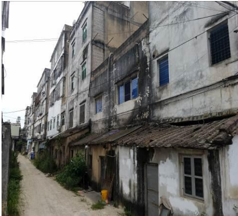
项目西北面工业厂房
