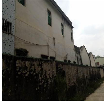
项目西南面临街商铺
