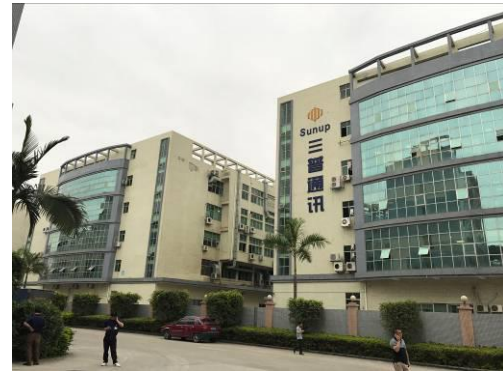
项目北面工业厂房
