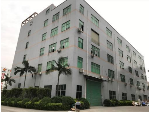
项目东面工业厂房
