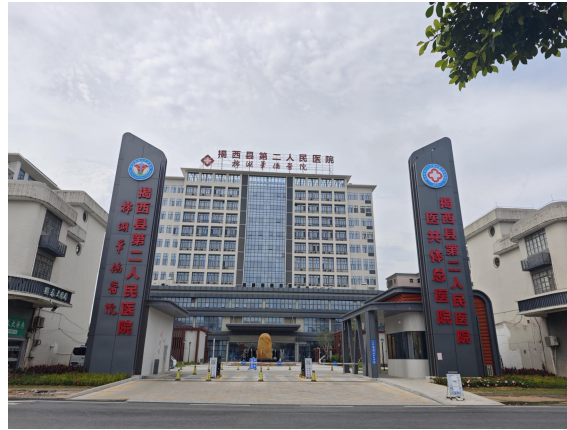
污水处理站上方入口广场
