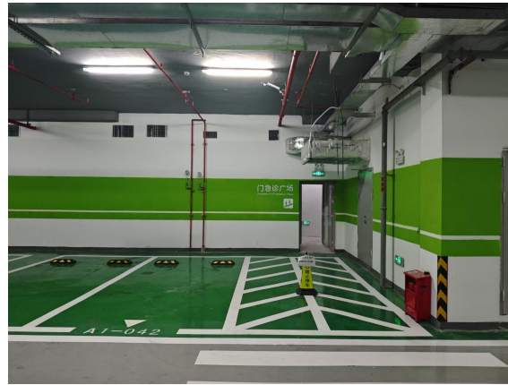
污水处理站西面停车场（负一层）
