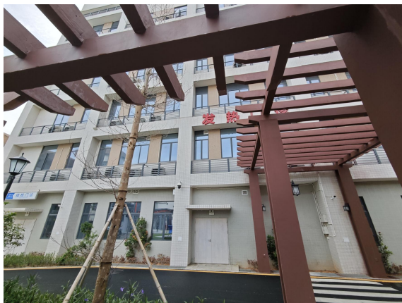
预消毒池东面感染科大楼
