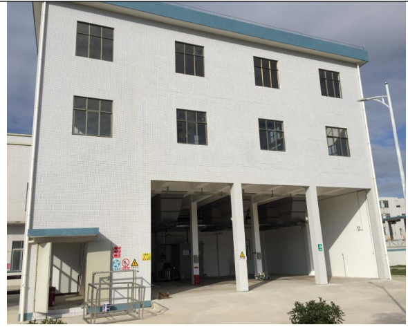
脱泥房，一楼是污泥泥斗
