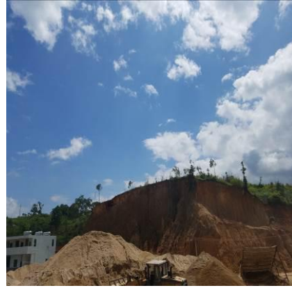
项目东面荒地
