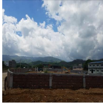
项目南面在建厂房
