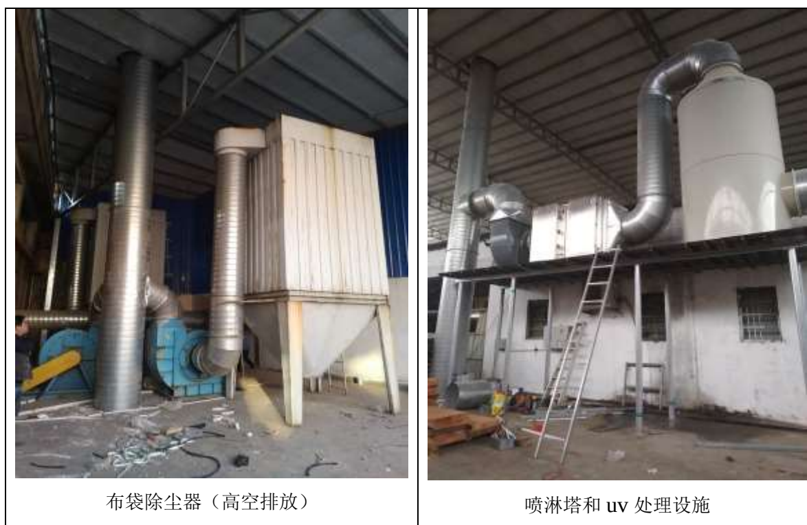
图 3.2-1 已建废气收集与处理设施
