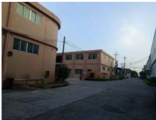
项目南侧工业厂房
