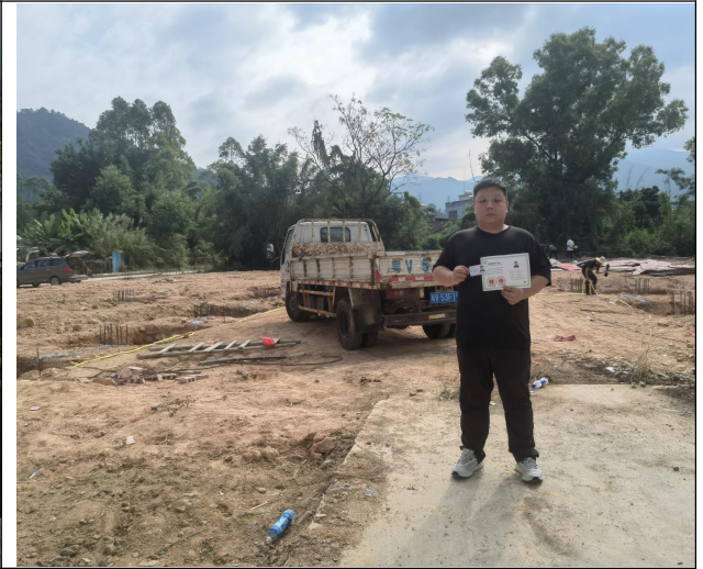
工程师现场照片
