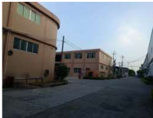
项目南侧工业厂房
