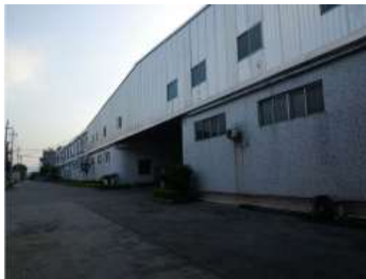
项目西南侧工业厂房
