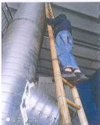
图六 粉尘废气排放口（处理后）
