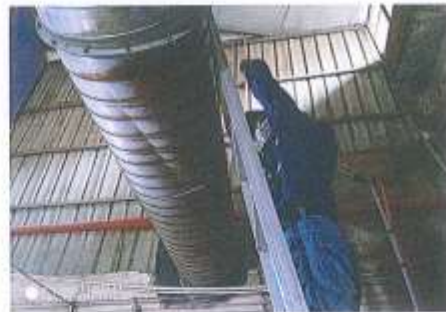
图五 粉尘废气2号采样口(处理前)
