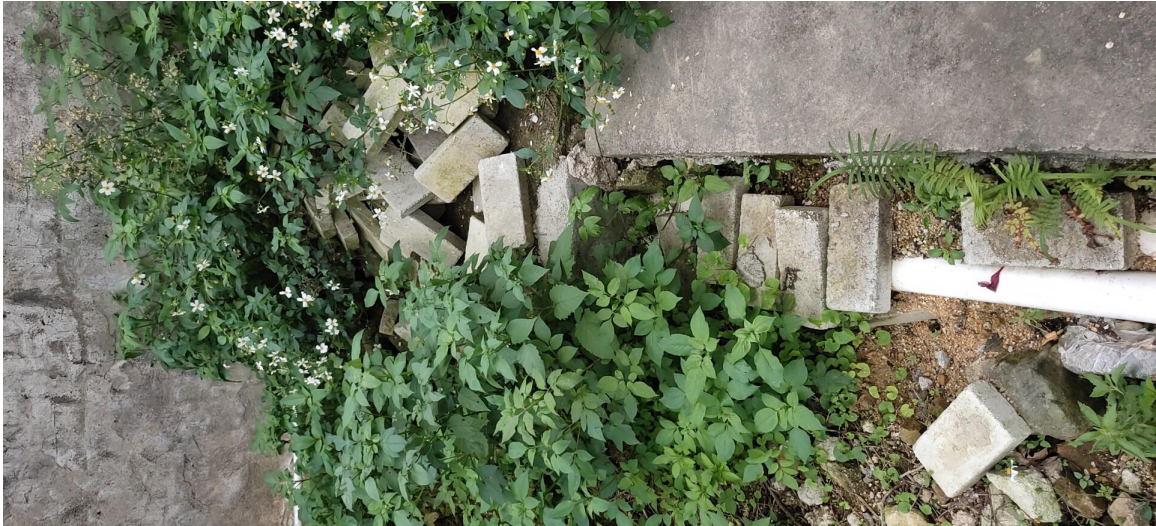
图 4.1-1 生活污水处理设施
