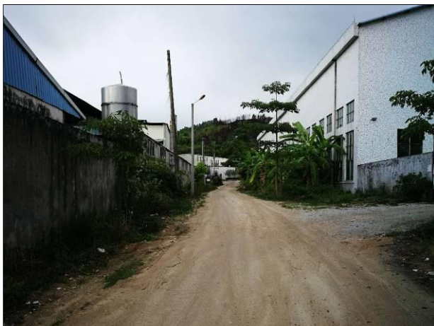
东面厂区前道路
