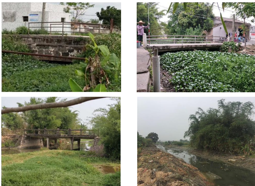
图 1 本项目现状图片
