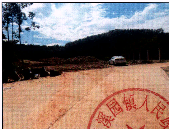
项目终点现状
