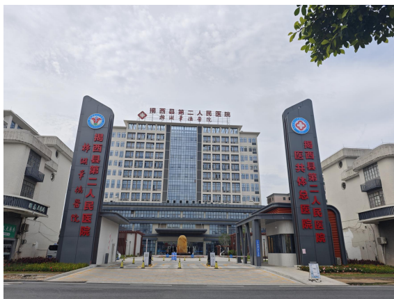
污水处理站上方入口广场
