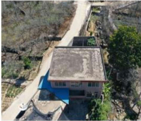
厂房外貌全景
