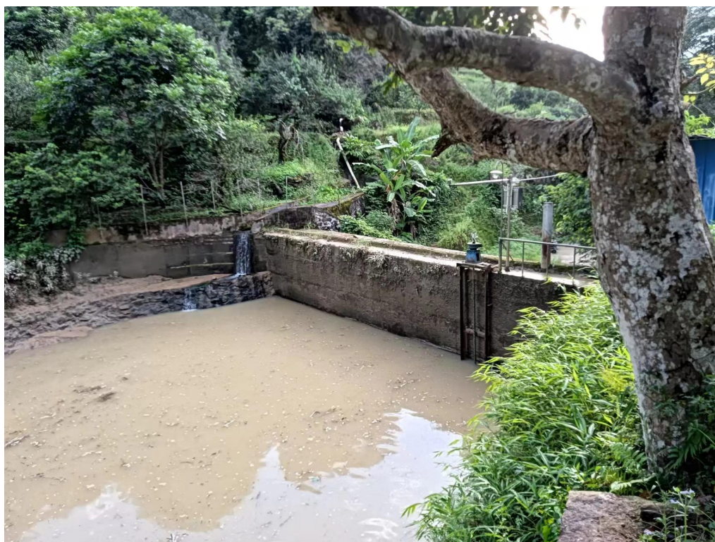
拦水大坝全貌
