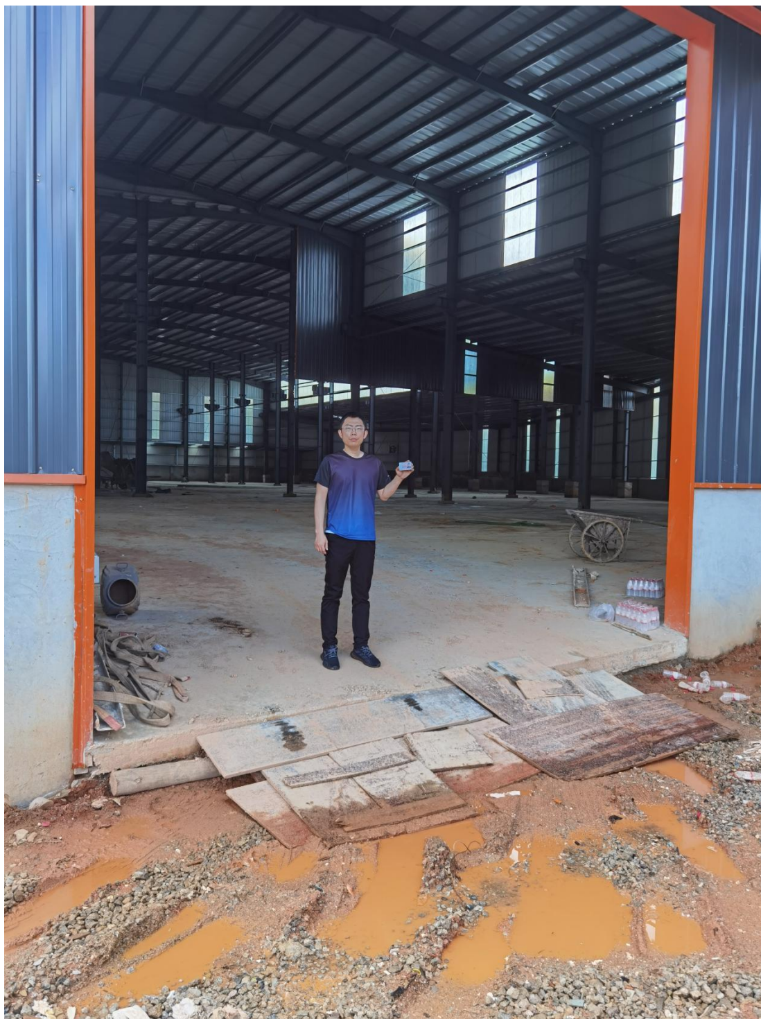
附图 14 工程师现场勘察图
