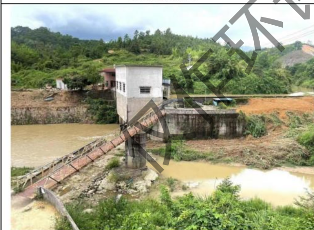
发电厂房区全景现状
