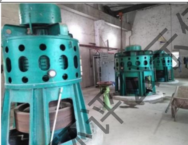
发电厂房内部现状
