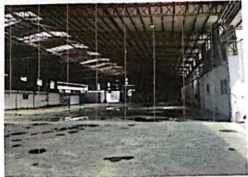
项目车间内部 3
