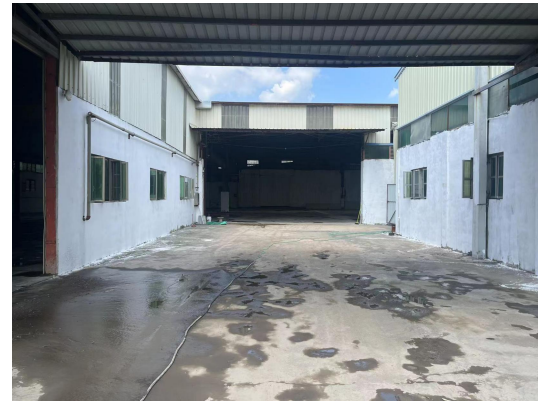
项目厂区内部
