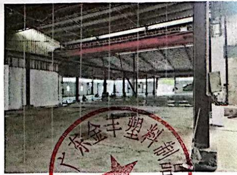
项目车间内部 2
