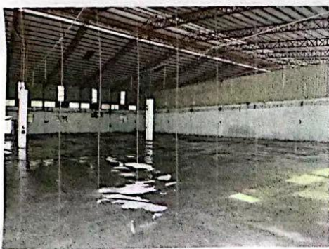
项目车间内部 1
