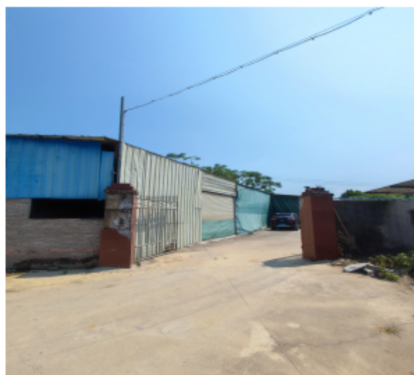
项目厂区大门
