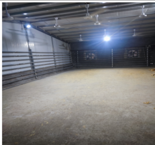
项目厂区现状图 2
