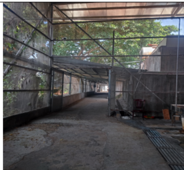
项目厂区现状图 1
