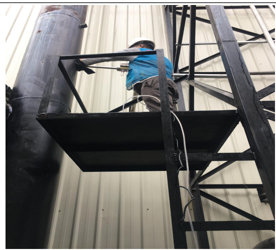
锅炉废气采样图
